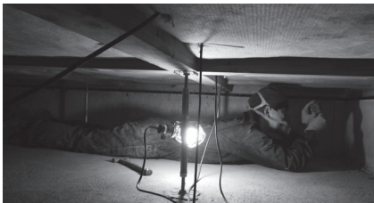
点検作業の様子
