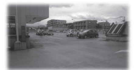
図2：防水工事 屋上駐車場も可能 最長15年保証も可能
